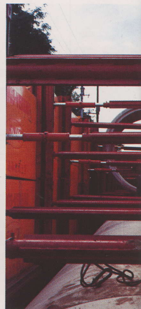
同左管布設作業
