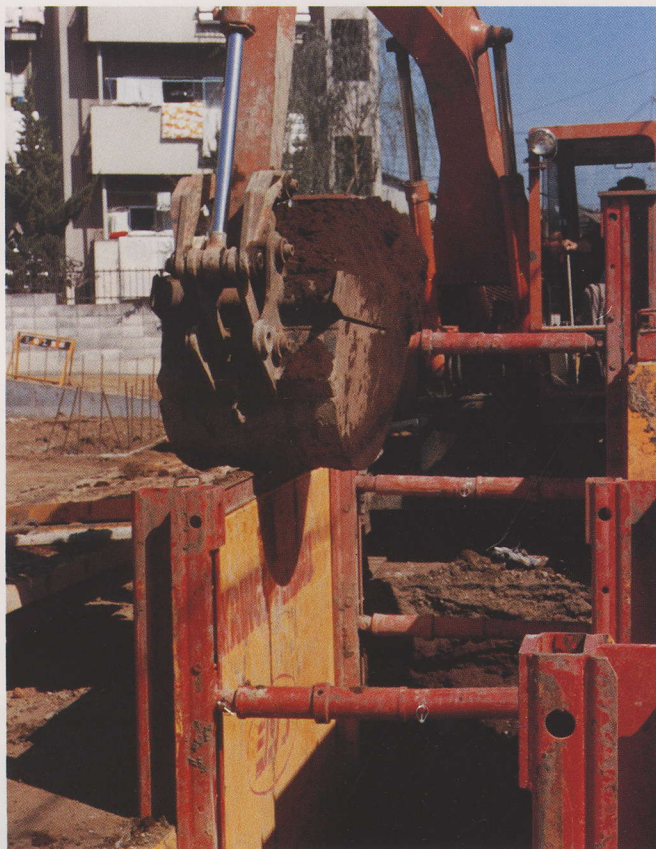
埼玉県浦和市下水道工事 管径φ500mm
