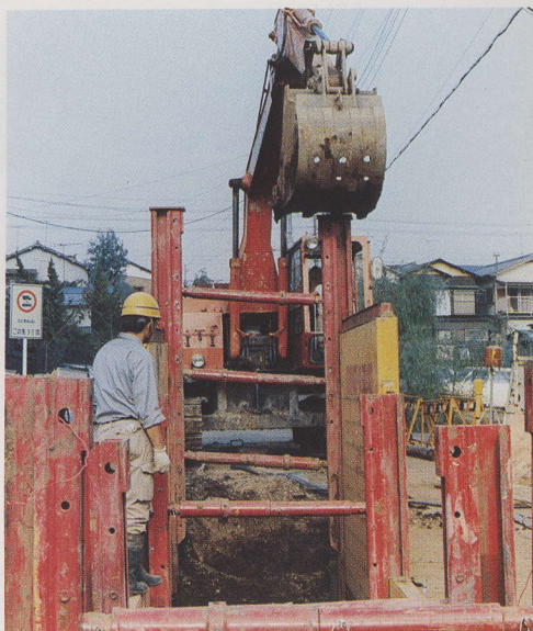
埼玉県浦和市下水道工事 管径φ500mm
