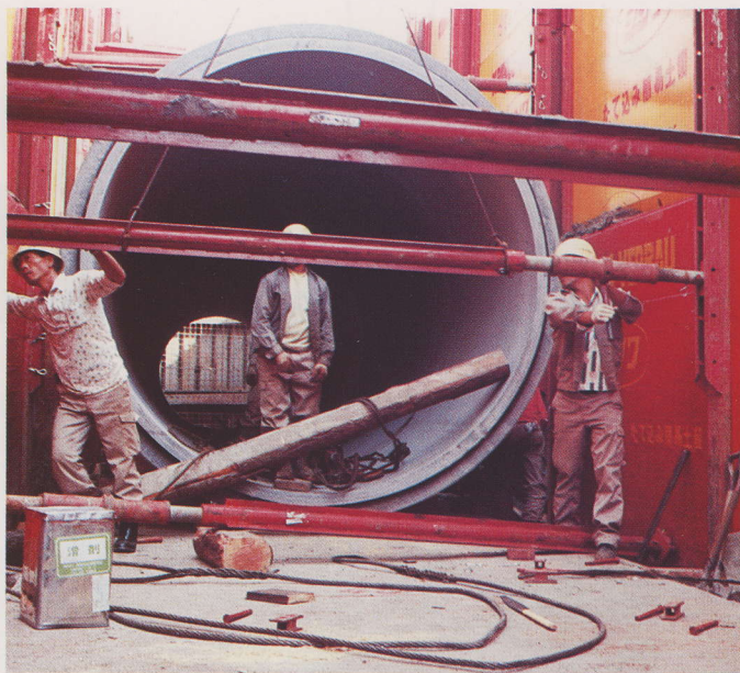
北海道滝川市下水道工事 管径φ2,600mm(DG型)
