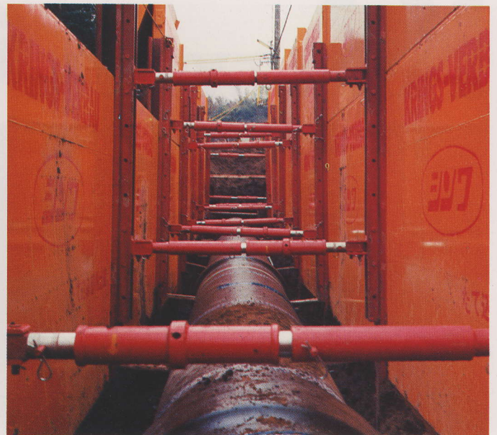
木更津市水道管理設工事 \phi 600\text{mm} \times 6\text{m} (KR-SS型) 管理設工事
