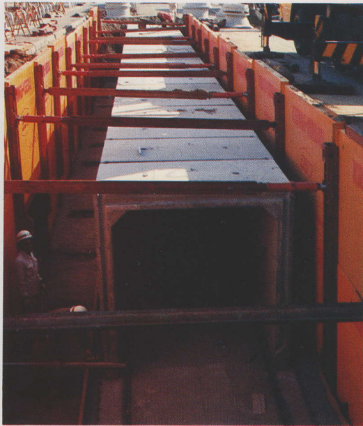
熊本市配水路工事(ボックスカルバート) 2000 \times 2200\text{mm} (KR型) \phi 600\text{mm} } 併設
