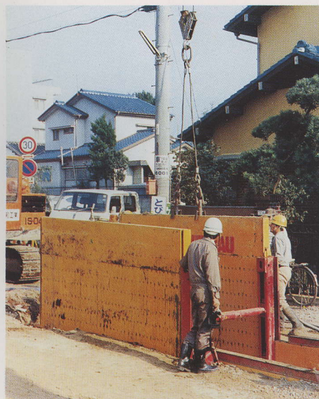
埼玉県浦和市下水道工事 管径φ500mm
