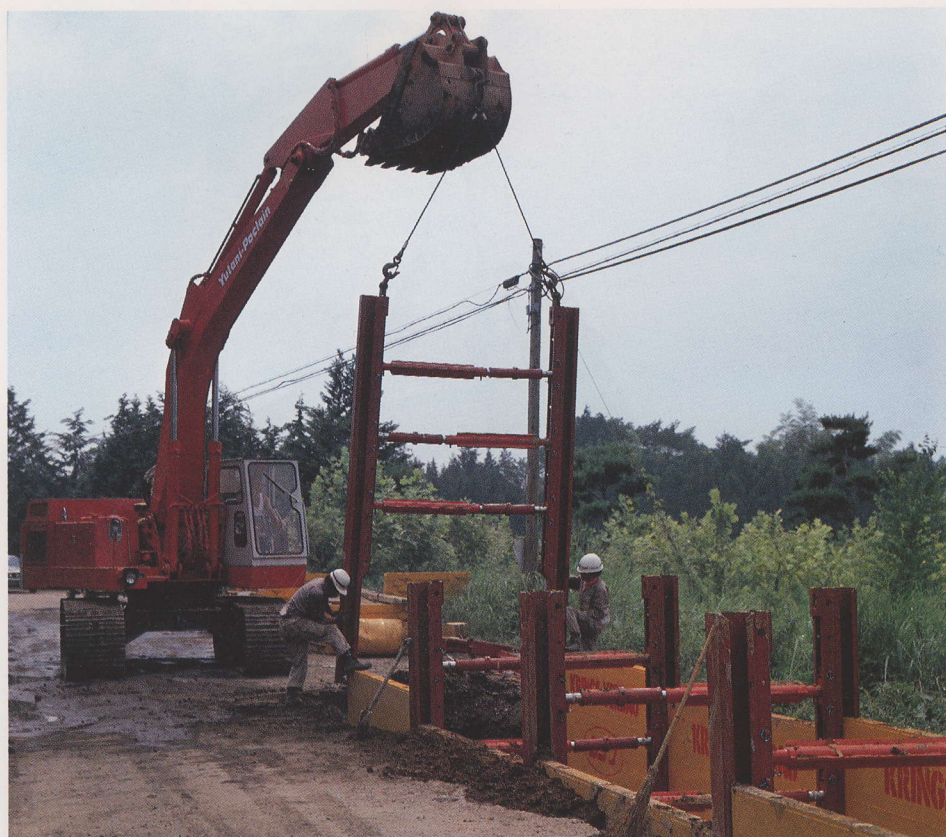
栃木県矢板市下水道工事 管径φ900mm
